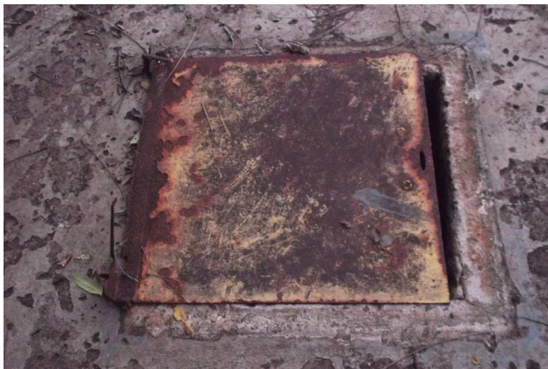
Figura 24 – Dimensões da tampa metálica: 85 cm x 80 cm
