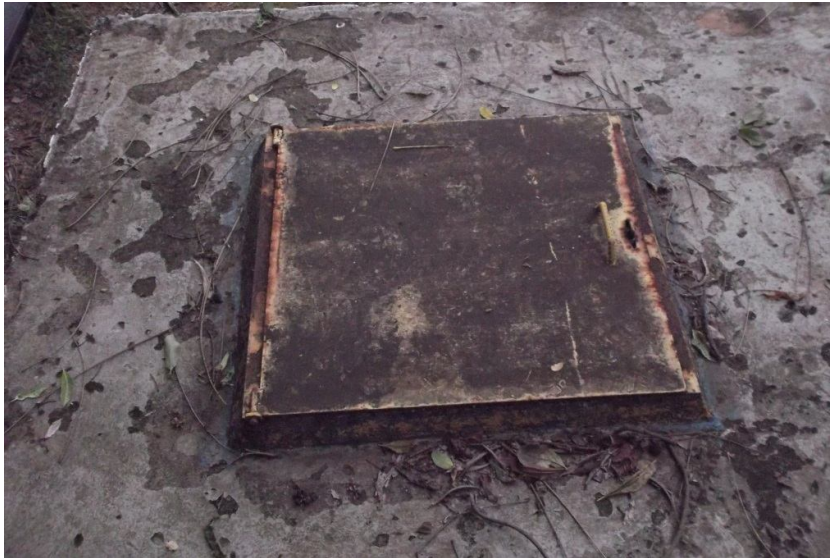
Figura 25 – Dimensões da tampa metálica: 75 cm x 75 cm
