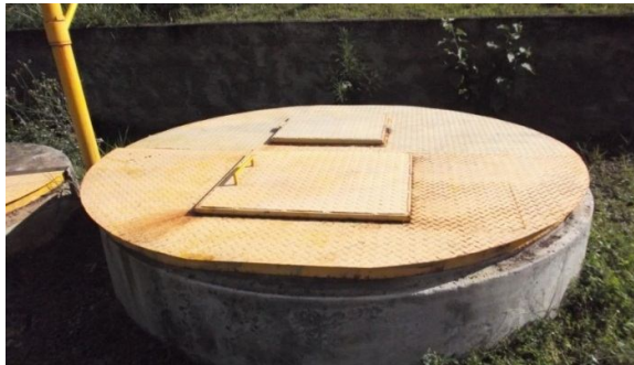
Figura 53 – Dimensões da tampa metálica: Ø 250 cm – dividido em duas partes
