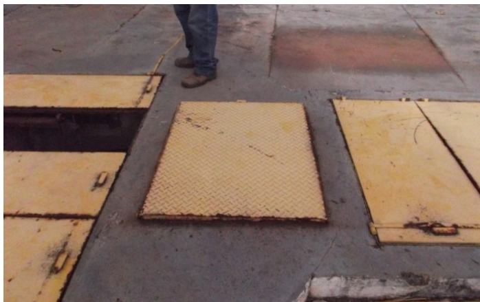
Figura 48 – Dimensões das tampas metálicas: 80 cm x 105 cm
