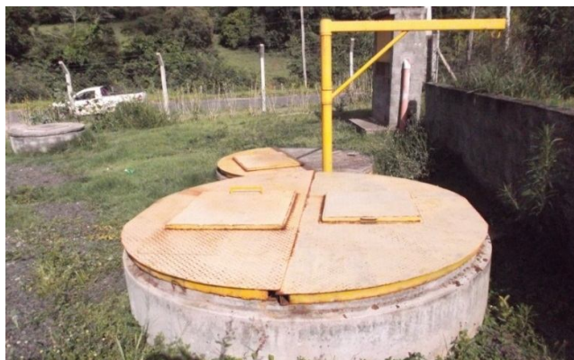
Figura 55 - Vista geral das tampas metálicas
