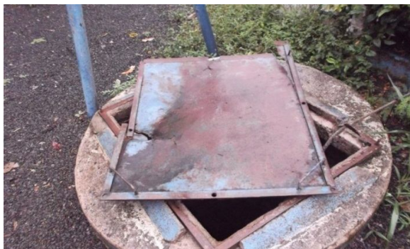
Figura 40 – Dimensões da tampa metálica: 95 cm x 1.05 cm
