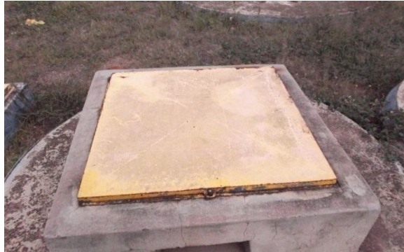
Figura 18 – Dimensões da tampa metálica: 85 cm x 85 cm
