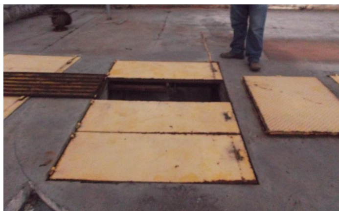
Figura 49 - Dimensões: 4 unidades de 125 cm x 225 cm com trava para cadeado
