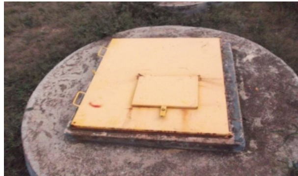
Figura 19 – Dimensões da tampa metálica: 95 cm x 95 cm
