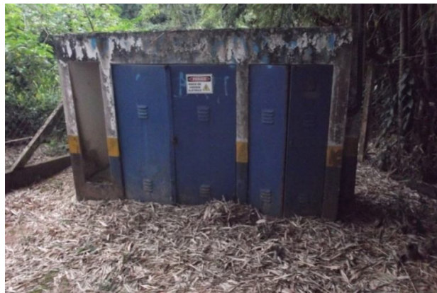
Figura 28 – Dimensões da porta metálica: 130 cm x 150 cm
