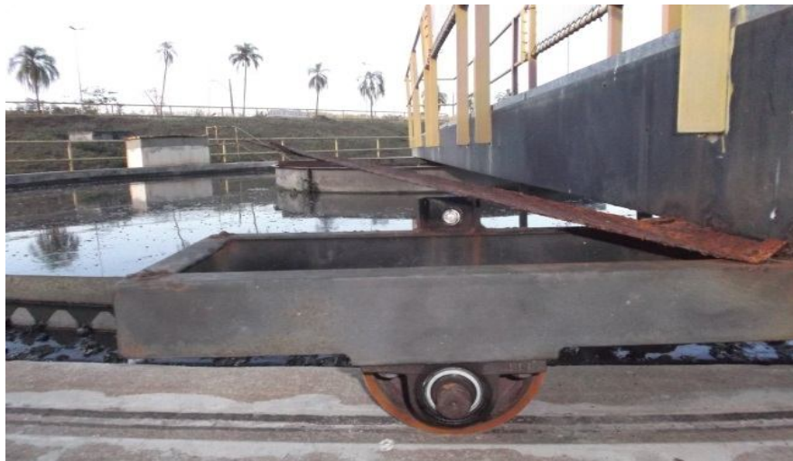
Figura 80 – Foto da local para instalação da chapa protetora para o motor das Pontes Removedoras de Lodo dos decantadores
