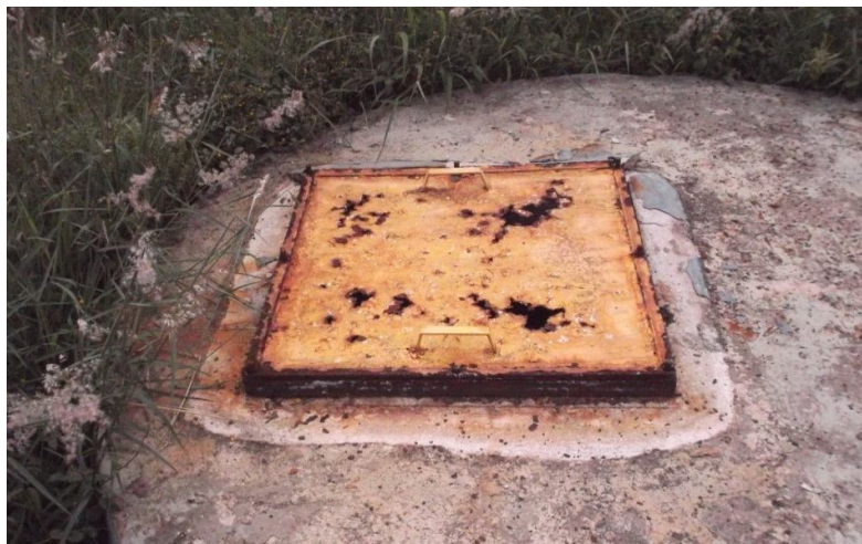
Figura 11– Dimensões da tampa metálica: 80 cm x 80 cm
