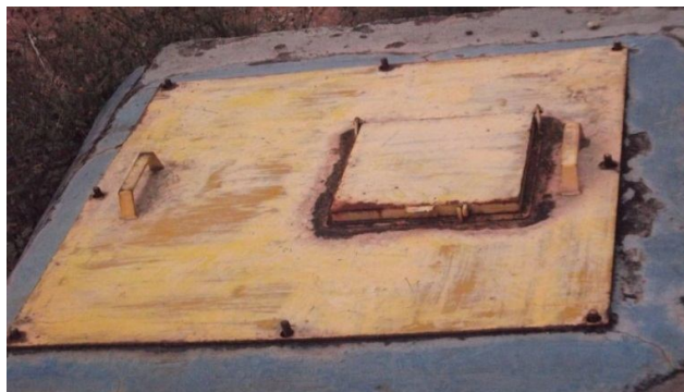
Figura 15 – Dimensões da tampa metálica: 95 cm x 95 cm
