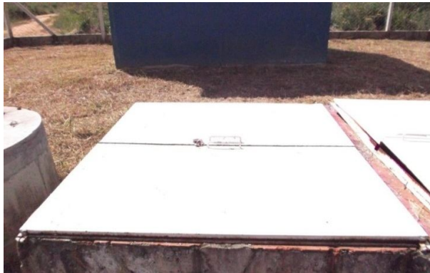
Figura 69 – Dimensões da tampa metálica: tampa 90 cm x 90 cm
