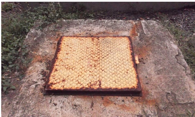
Figura 61 – Dimensões da tampa metálica: tampa 63,5 cm x 63 cm
