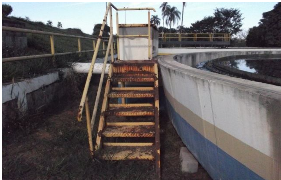
Figura79 – Foto da escada a ser recuperada
