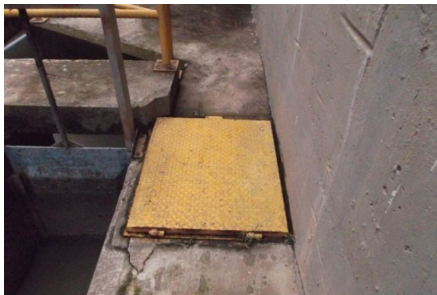
Figura 64 – Dimensões da tampa metálica: tampa 81 cm x 67 cm
