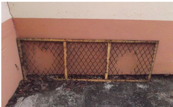
Figura 66 – Dimensões do suporte metálico em tela expandida: tampa 160 cm x 59,5 cm
