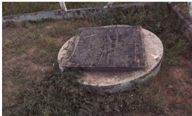
Figura 20 – Dimensões da tampa metálica: 90 cm x 90 cm
