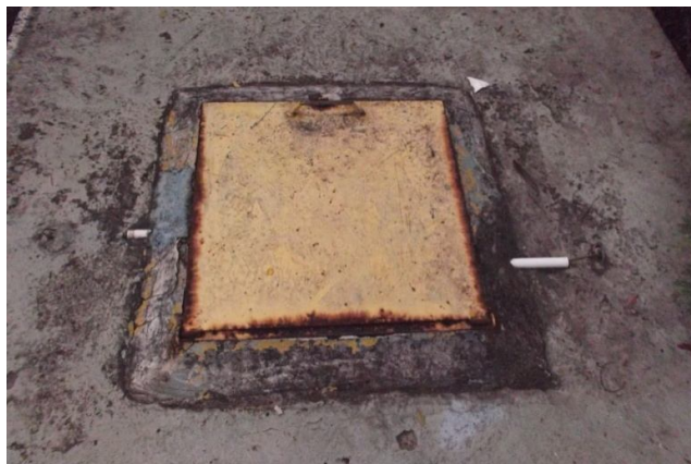
Figura 34 - Dimensões da tampa metálica: 75 cm x 75 cm
