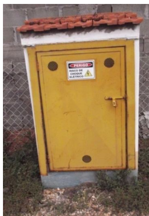
Figura 17 – Porta metálica com ferrolho: 95 cm x 115 cm
