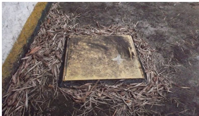
Figura 29 – Dimensões da tampa metálica: 80 cm x 80 cm
