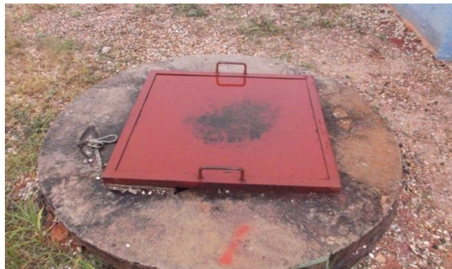
Figura 38 – Dimensões da tampa metálica: 90 cm x 90 cm
