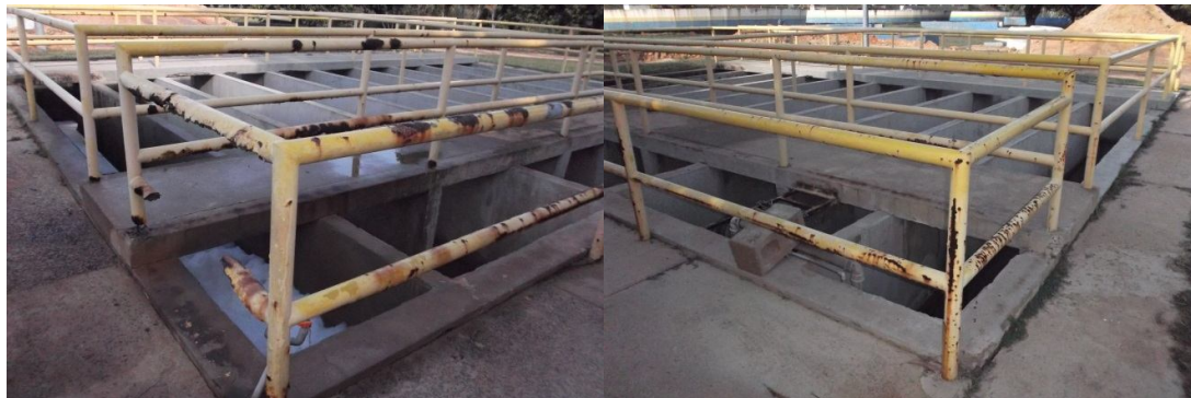
Figura 83– Foto da local para reforma do guarda corpo do Tanque de contato
