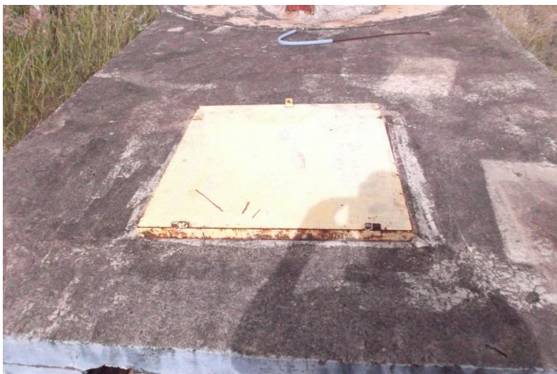
Figura 31 – Dimensões da tampa metálica: 75 cm x 75 cm
