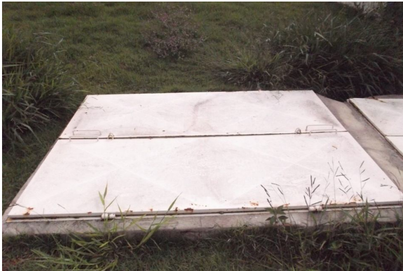
Figura 23 – Dimensões da tampa metálica: 170 cm x 230 cm
