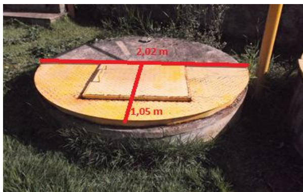
Figura 54 – Dimensões da tampa metálica: 202 cm x 105 cm de raio – meio círculo
