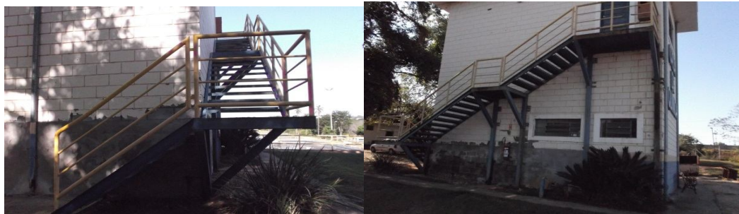
Figuras 81 – Foto da escada de acesso à Casa de Química
