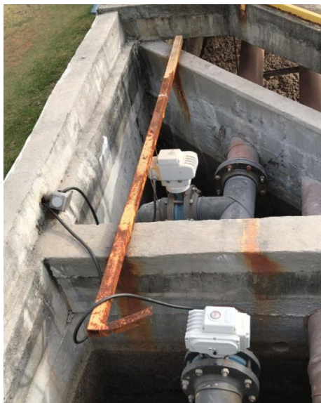
Figura 86: Foto da local para instalação do suporte para registros
