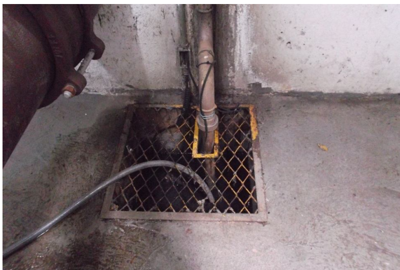
Figura 68 – Dimensões da grade metálica: tampa 62 cm x 61,5 cm
