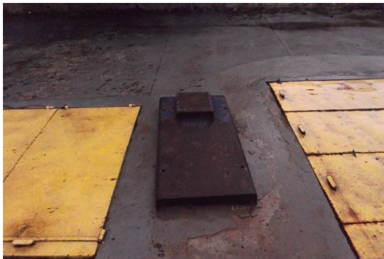
Figura 58 – Dimensões da tampa metálica: 80 cm x 55 cm
