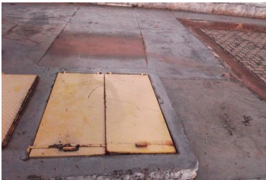
Figura 47 – Dimensões das tampas metálicas: 2 unidades de 130 cm x 110 cm
