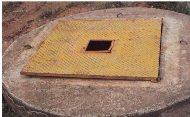
Figura 14 – Dimensões da tampa metálica: 115 cm x 115 cm
