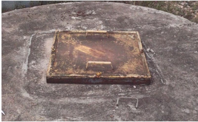
Figura 12 – Dimensões da tampa metálica: 60 cm x 60 cm
