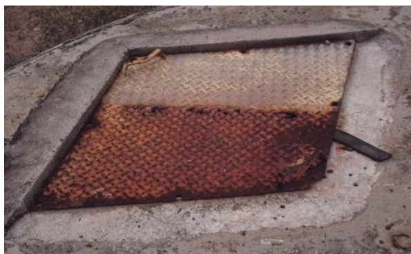
Figura 16 – Dimensões da tampa metálica: 85 cm x 85 cm
