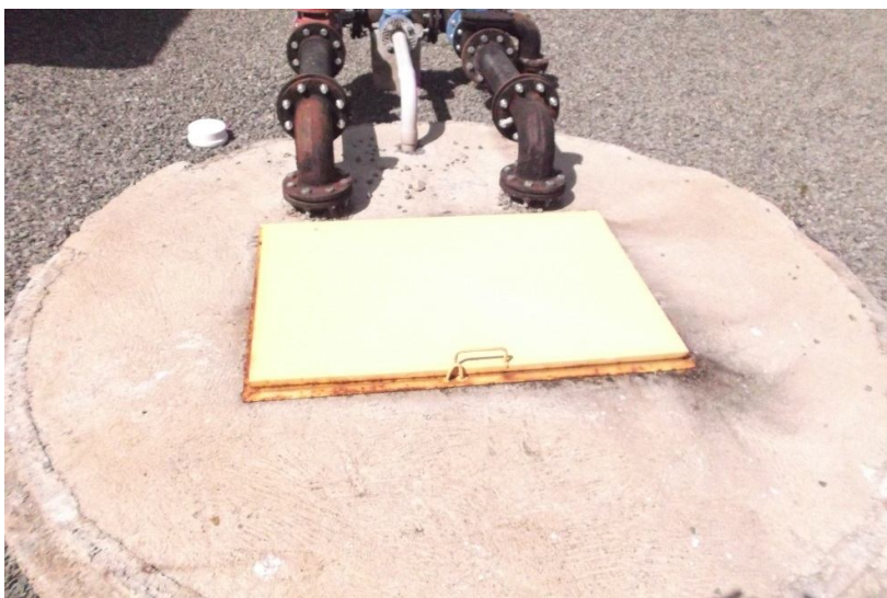
Figura 73 – Dimensões da tampa metálica: tampa 80 cm x 1,10 cm
