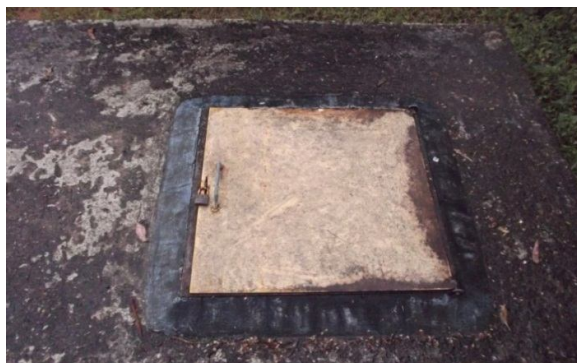
Figura 44 – Dimensões da tampa metálica: 90 cm x 90 cm
