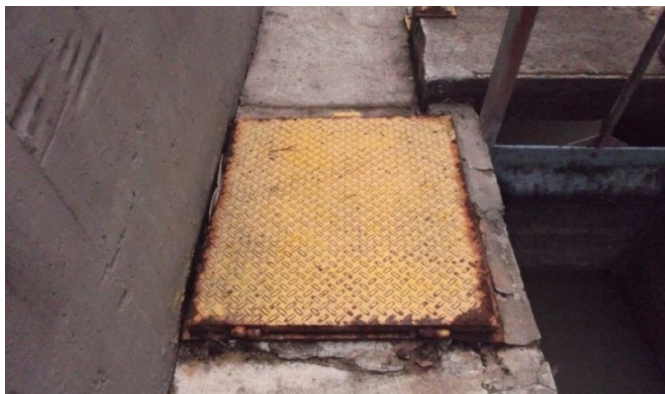
Figura 65 – Dimensões da tampa metálica: tampa 81 cm x 67 cm
