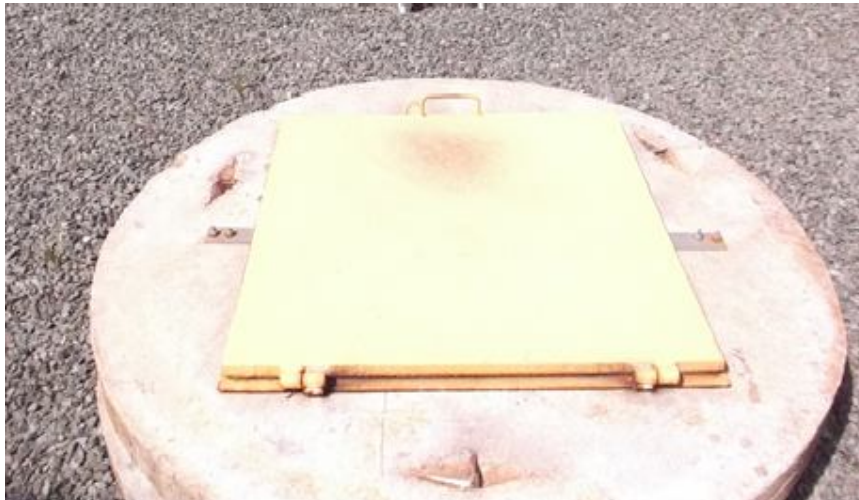
Figura 72 – Dimensões da tampa metálica: tampa 90 cm x 90 cm
