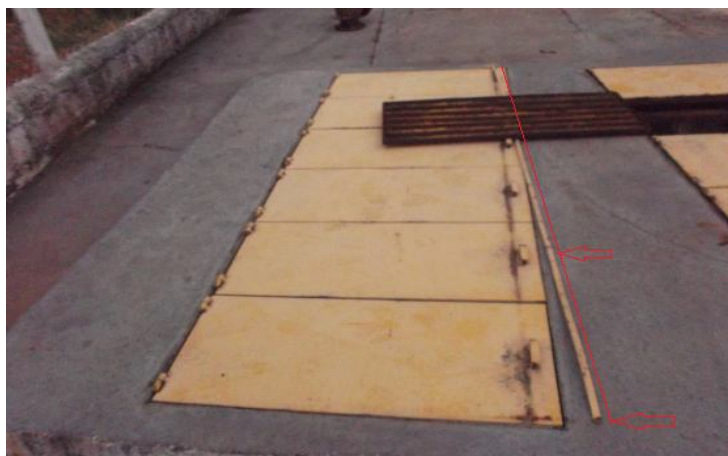
Figura 50 - Observação: trava para tampas com lingueta para cadeado de ferro de 5
