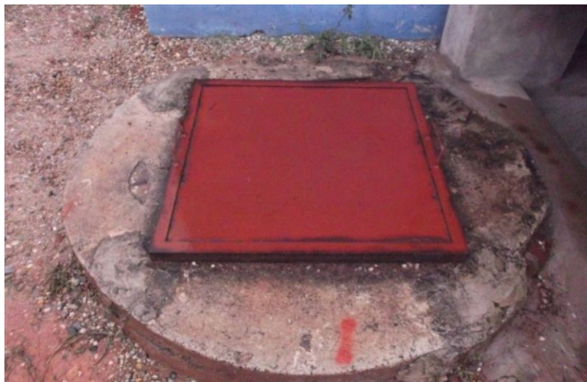
Figura 37 – Dimensões da tampa metálica: 90 cm x 90 cm
