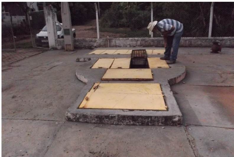
Figura 52 - Vista geral das tampas metálicas
