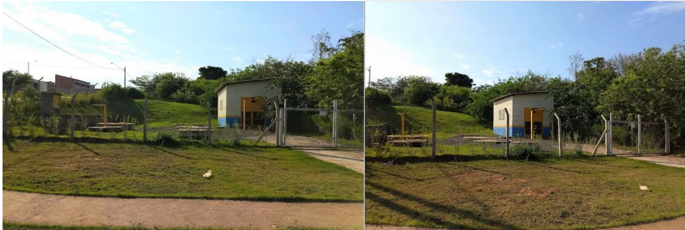
Figura 264: Estação Elevatória de Esgoto Bruto – EEEB Vila Primavera
