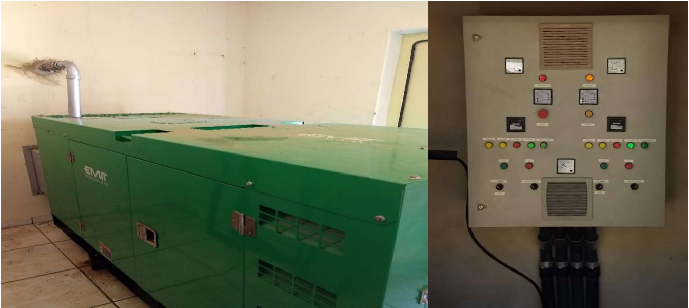
Figura 193: Estação Elevatória de Esgoto Bruto – EEEB 03B.
