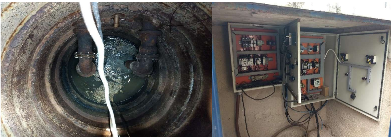
Figura 167: Ilustração dos Equipamentos da Estação Elevatória de Esgoto Bruto (EEEB - Planalto).
