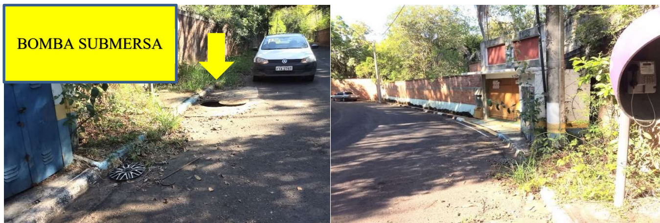
Figura 223: Estação Elevatória de Esgoto Bruto - EEEB Roseira de Cima III
