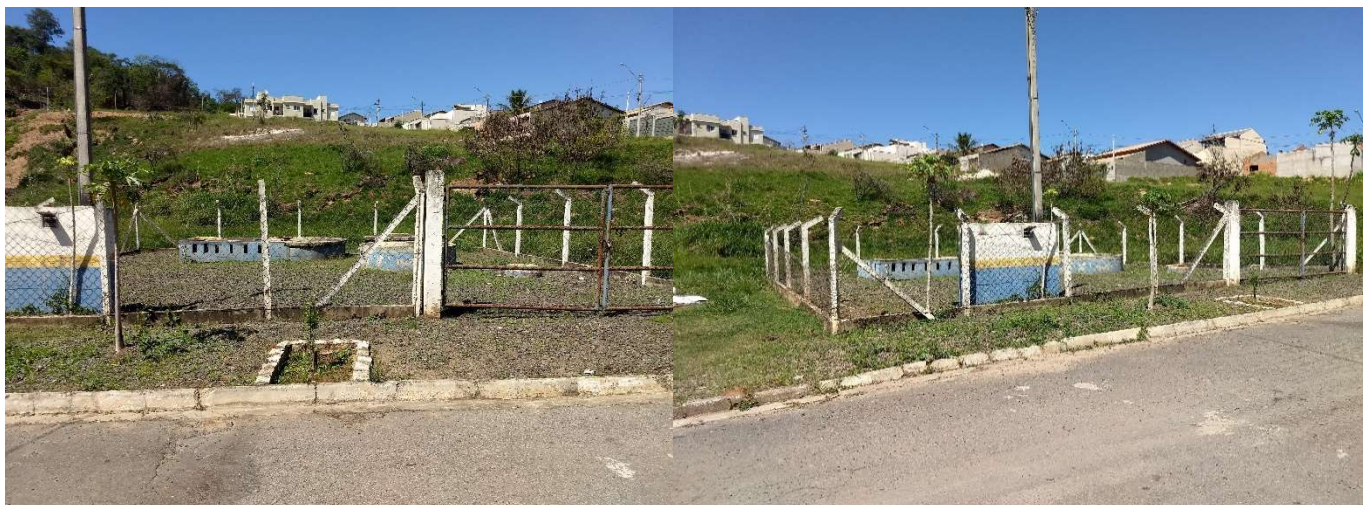
Figura 160: Estação Elevatória de Esgoto Bruto – EEEB Nova Jaguariúna III.
