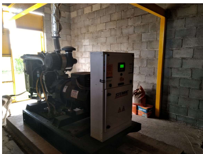
Figura 43: Foto do Conjunto Moto Gerador da ETE Vila Primavera
