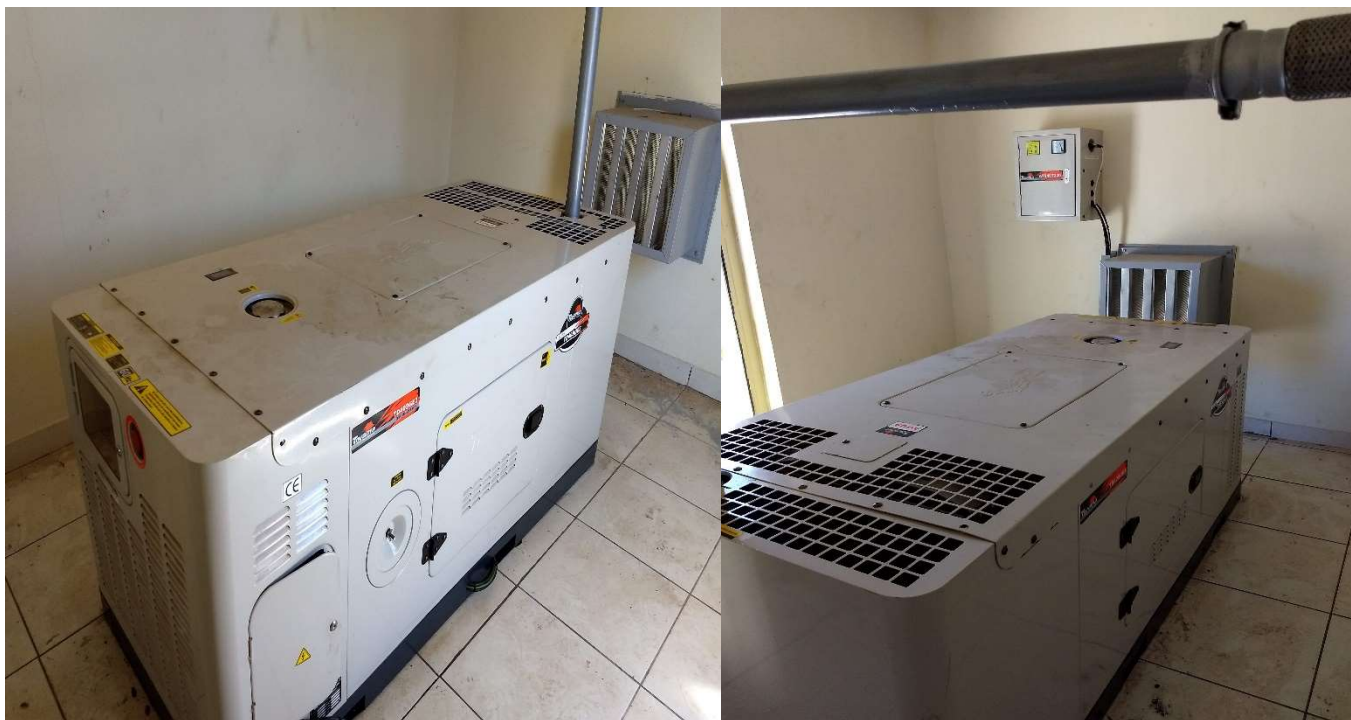
Figura 204: Estação Elevatória de Esgoto Bruto - EEEB 04
