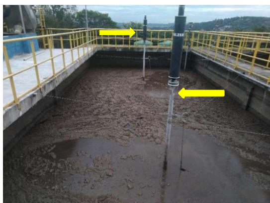
Figura 15: Fotos dos aeradores e misturadores instalados no reator 1, à direita e no reator 2 à esquerda
