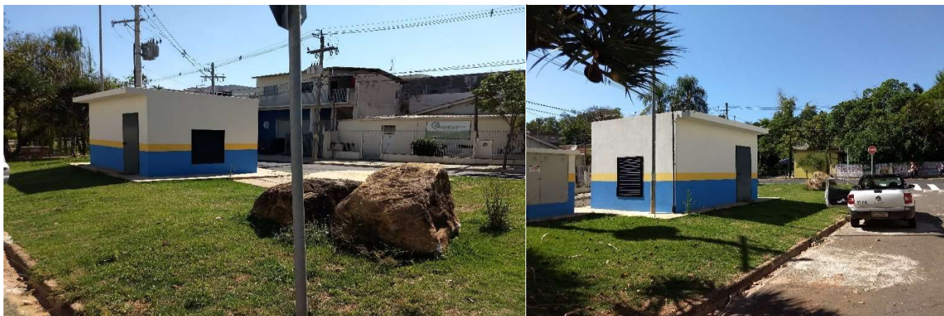
Figura 166: Estação Elevatória de Esgoto Bruto – EEEB 03.
