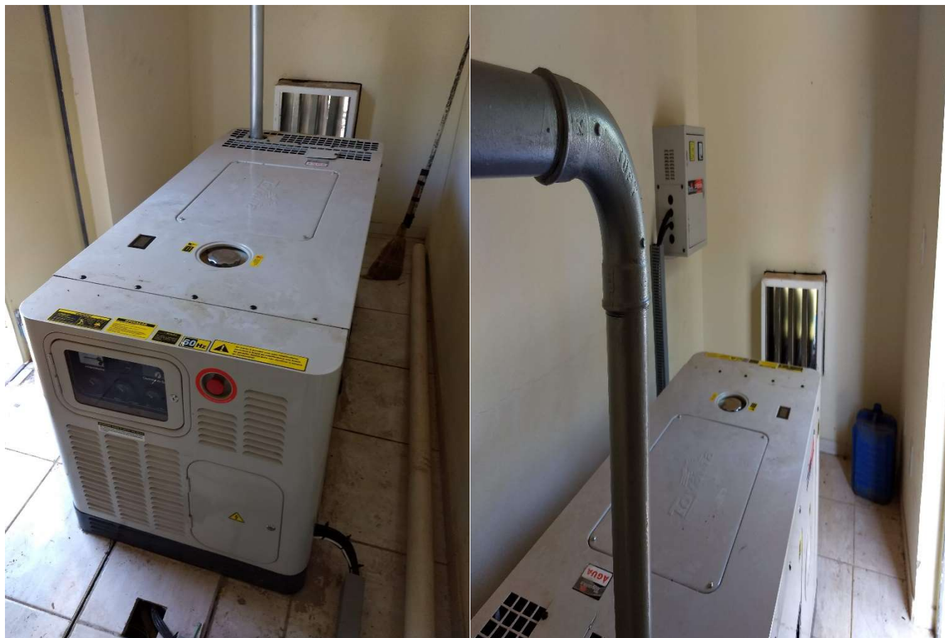
Figura 213: Estação Elevatória de Esgoto Bruto - EEEB 04 A.
