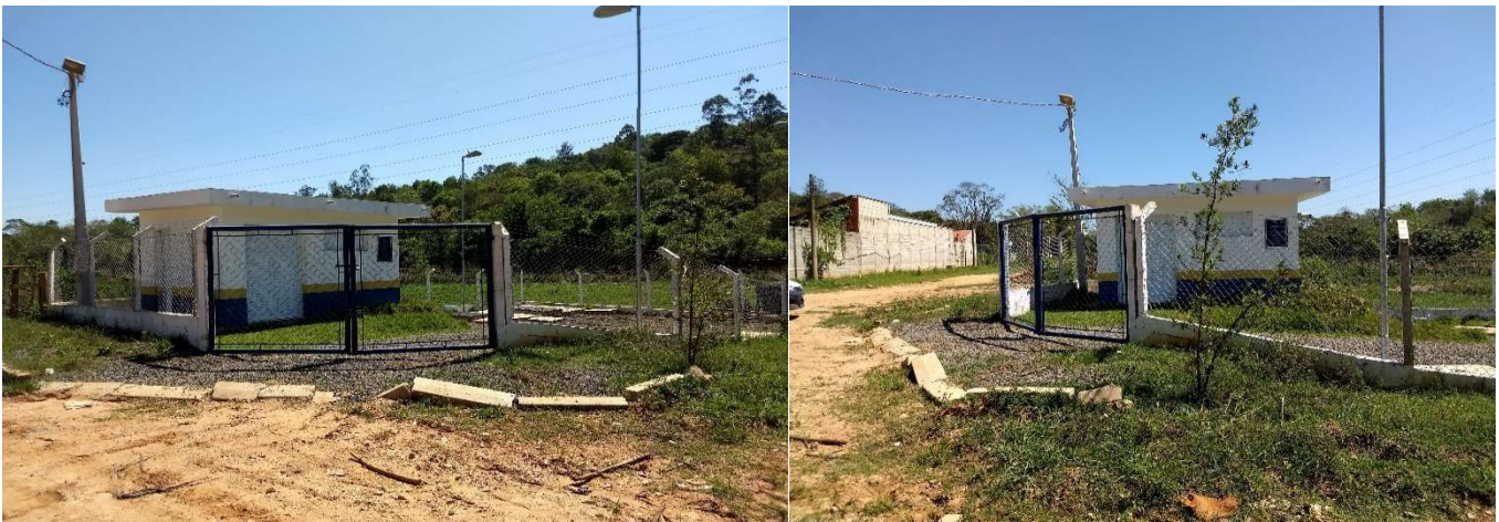
Figura 273: Estação Elevatória de Esgoto Bruto – EEEB Capela do Santo Antônio.
