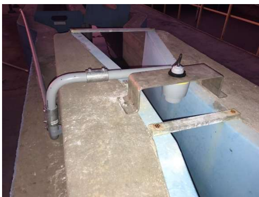
Figura 48: Ilustração do medidor de vazão da marca Vega instalado na ETE Camanducaia, na ETE Camanducaia e na EEBB Nove, sendo à direita o sensor, e à esquerda o indicador.
