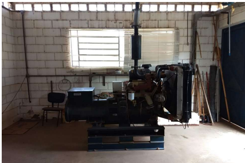
Figura 88: Ilustração do Grupo Gerador da EEEB Central
