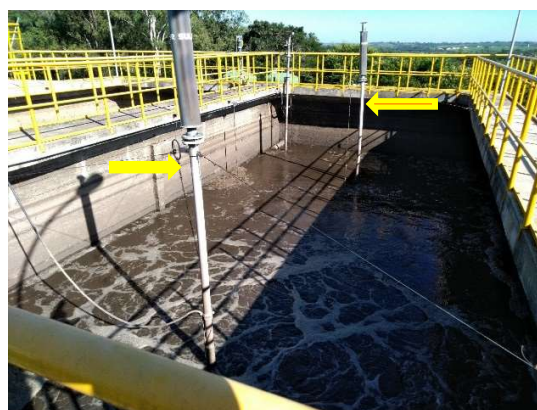
Figura 15: Fotos dos aeradores e misturadores instalados no reator 1, à direita e no reator 2 à esquerda
