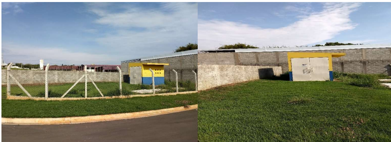
Figura 157: Estação Elevatória de Esgoto Bruto – EEEB Coração de Jesus.
