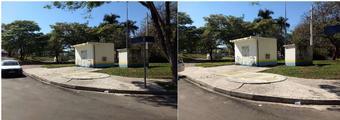
Figura 199: Estação Elevatória de Esgoto Bruto - EEEB 04.
