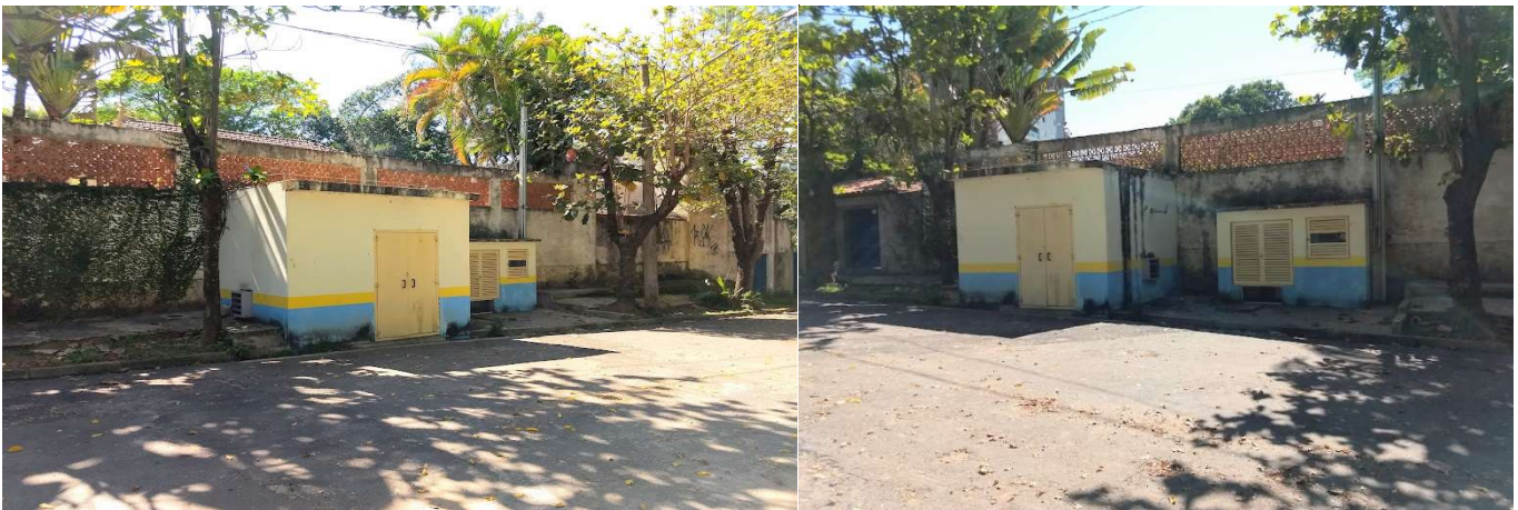
Figura 175: Estação Elevatória de Esgoto Bruto - EEEB 03A.
