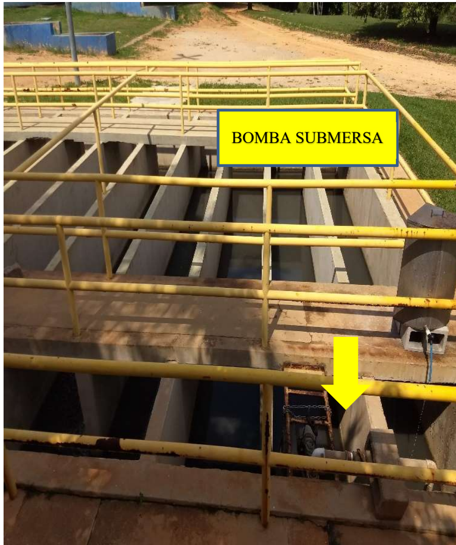
Figura 70: ETE – Estação de Tratamento de Esgoto. – Tanque de Contato
