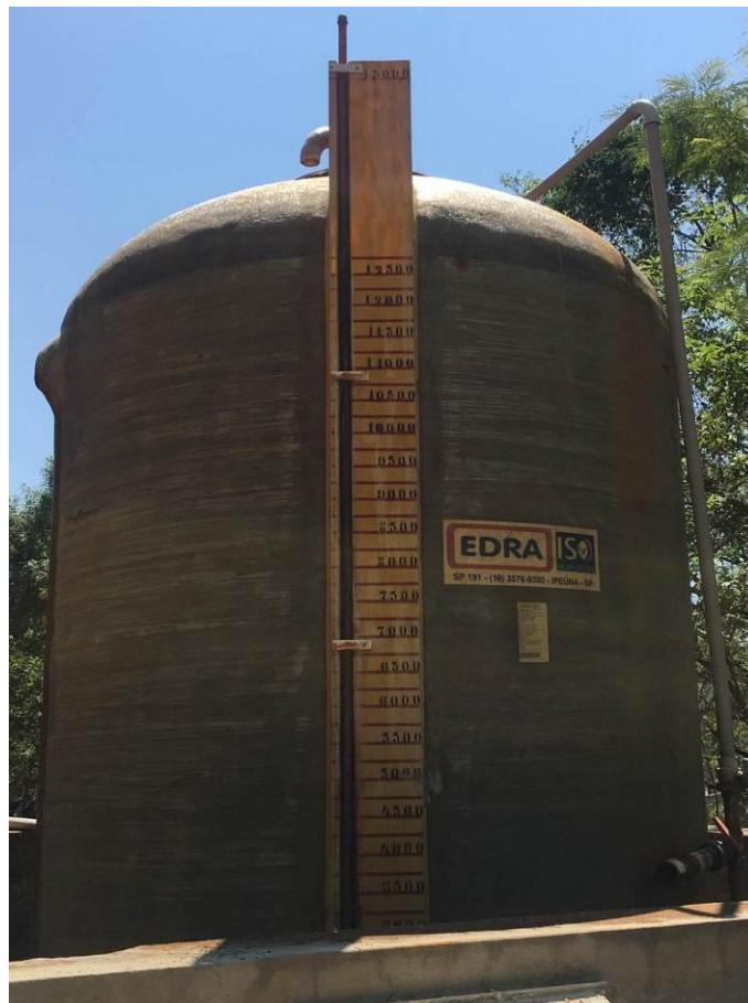
Figura 5. Situação do visor de nível existente nos TQ.03 e TQ.06.
