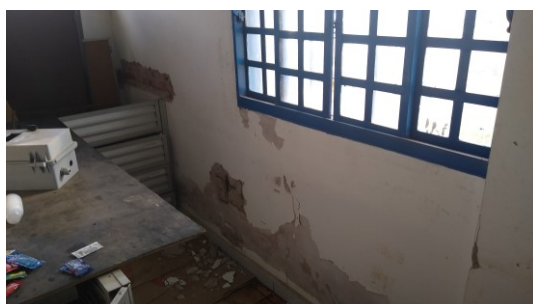
DETALHE DAS ANOMALIAS TÍPICAS NAS ARGAMASSAS DE REVESTIMENTO
