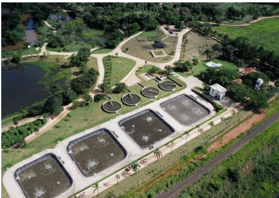
Figura 9 - Vista aérea da Estação de Tratamento de Esgoto Camanducaia
