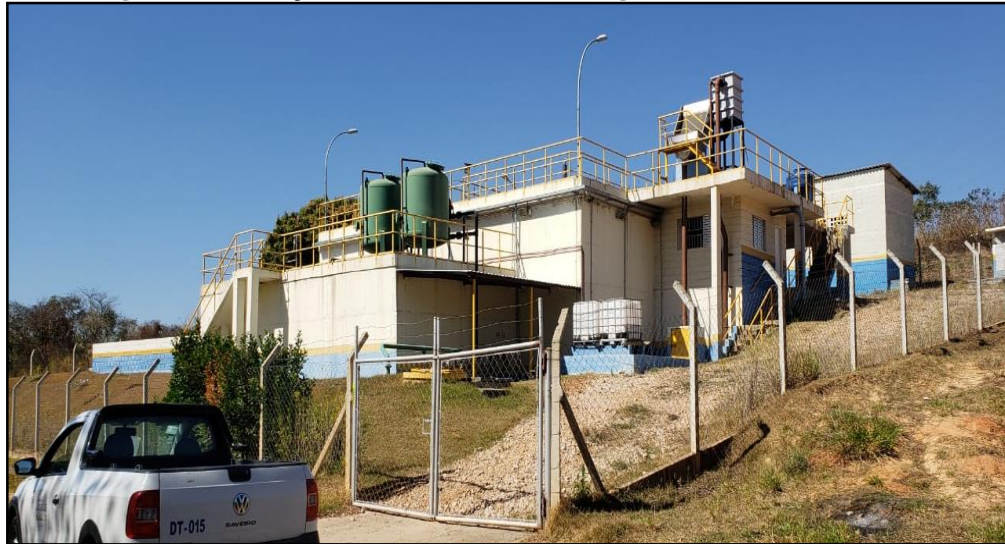
Figura 11 - Vista geral da Estação de Tratamento de Esgoto Vila Primavera.
