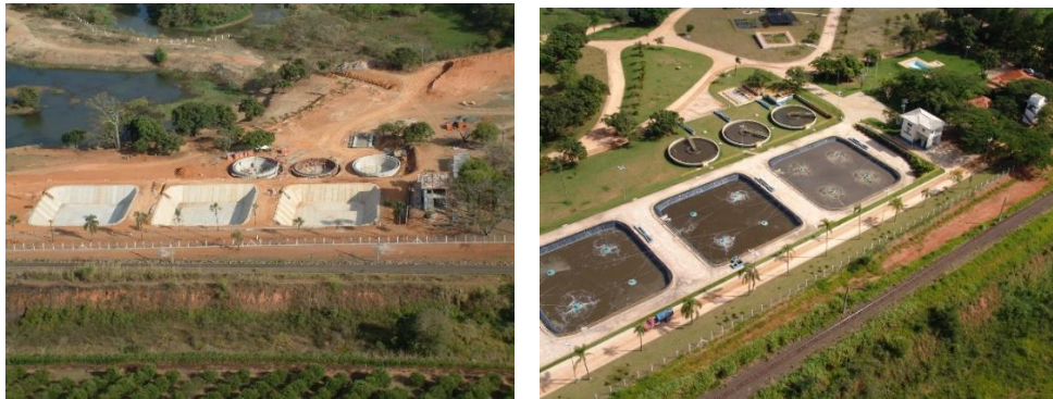
Figura 01: Ilustração da Lagoa de aeração com base de concreto e manta de impermeabilização
