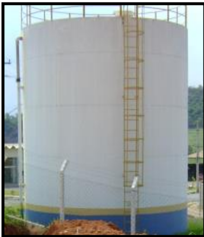
Figura 34 - Reservatório Elevado Pinheiros (200 m 3 ).
