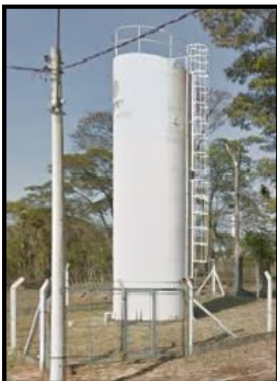
Figura 30 - Reservatório Zambom (100 m 3 ).
