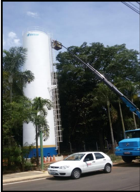
Figura 23 – Reservatório Roseira de Cima - (200 m 3 ).
