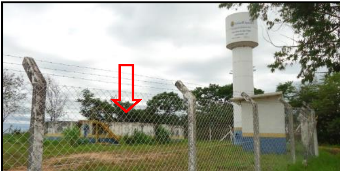
Figura 32 - Reservatórios Enterrado Florianópolis (1.000 m 3 )
