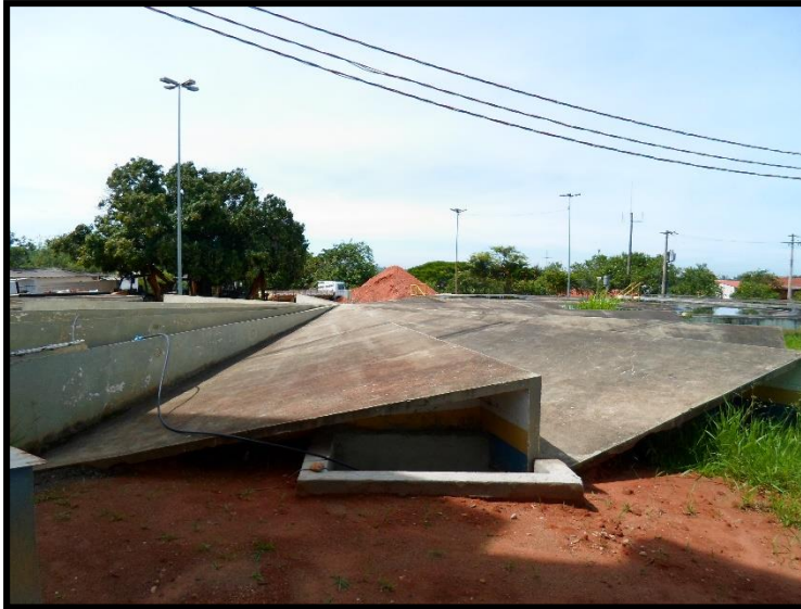
Figura 12 - Reservatório Semi-enterrado R1 - ETA Central.
