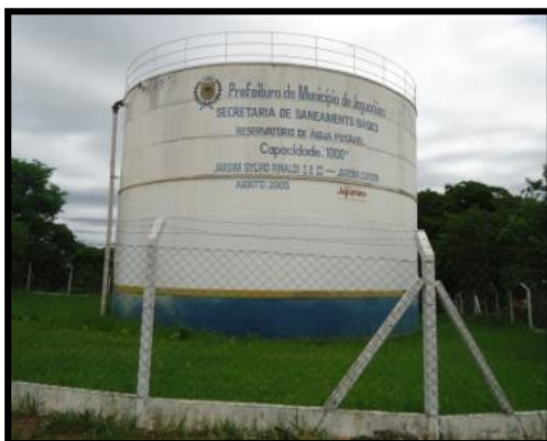
Figura 28 - Reservatório Sylvio Rinaldi I (1.000 m 3 ).
