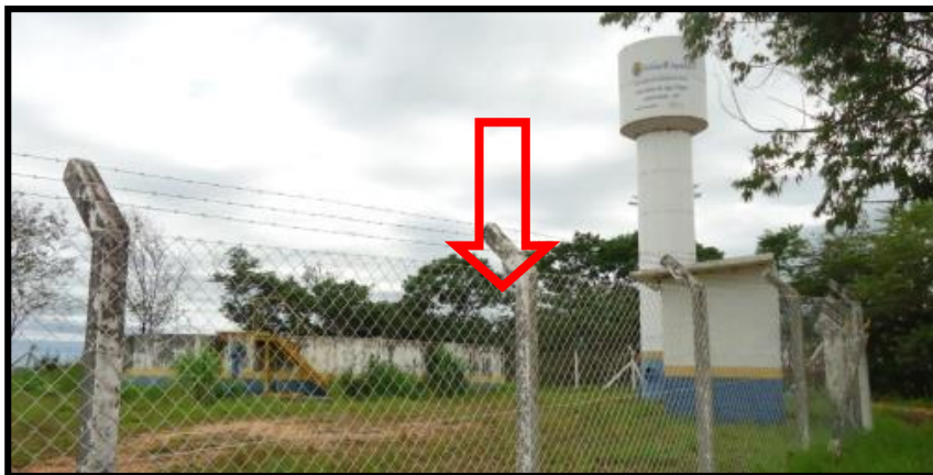
Figura 31 - Reservatórios Enterrado Florianópolis (1.000 m 3 )
