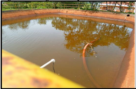
Figura 11 - Lagoa de reaproveitamento da ETA Central.
