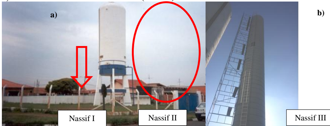
Figura 27 – Reservatório Enterrado Nassif I (1.200 m 3 ); Reservatório Elevado Nassif II (100m 3 ) e, Reservatório Elevado Nassif III (125 m 3 ).
