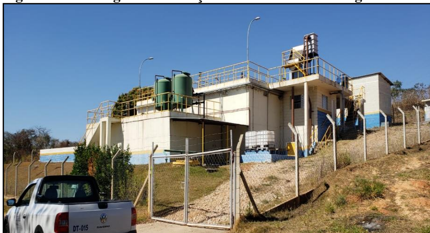
Figura 37 - Vista geral da Estação de Tratamento de Esgoto Vila Primavera.
