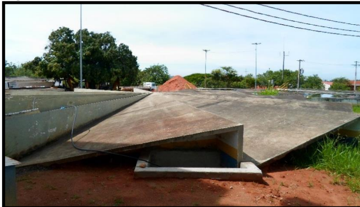
Figura 12 - Reservatório Semi-enterrado R1 - ETA Central.
