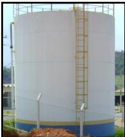
Figura 33 - Reservatório Elevado Pinheiros (200 m 3 ).
