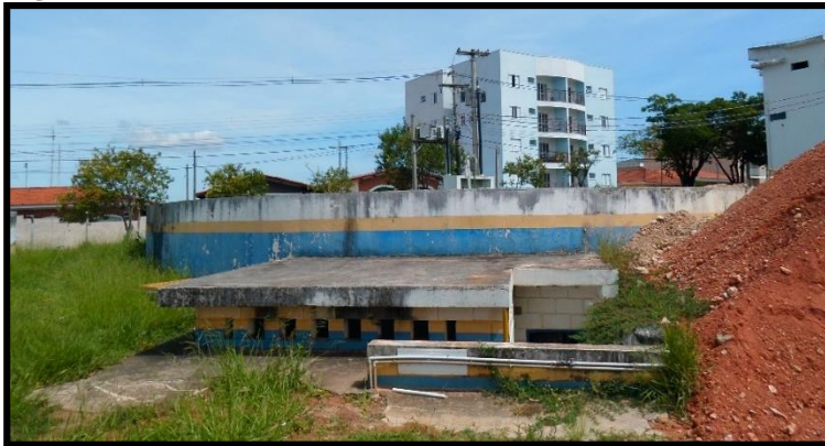
Figura 14 - Reservatório Semi-enterrado R3 - ETA Central.
