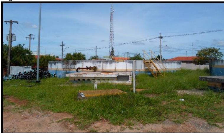
Figura 15 - Reservatório Semi-enterrado R4 - ETA Central.
