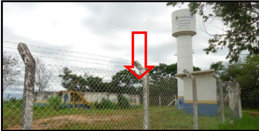
Figura 31 - Reservatórios Enterrado Florianópolis (1.000 m 3 )
