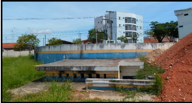
Figura 14 - Reservatório Semi-enterrado R3 - ETA Central.
