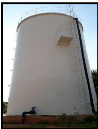
Figura 32 - Reservatórios Elevado Florianópolis II (300 m 3 ) que substituiu o Reservatório Elevado Florianópolis (30 m 3 ) - Terras do Capela
