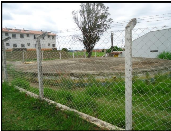
Figura 22 - Reservatório Cruzeiro do Sul (600 m 3 ).
