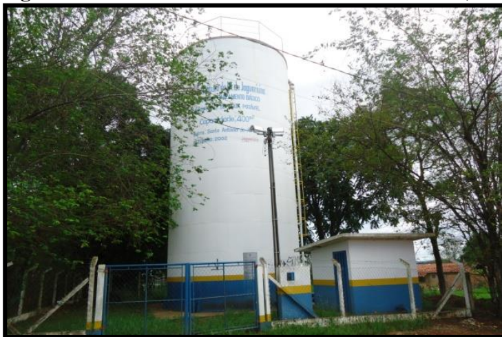
Figura 18 - Reservatório Santo Antônio do Jardim (400 m 3 ).
