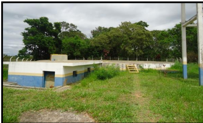
Figura 20 - Reservatório Nova Jaguariúna ( 600\text{ m}^3 ).
