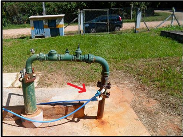
Figura17 - Dosagem de produtos químicos do Sistema Poço Santo Antônio.
