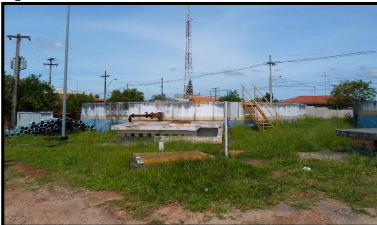
Figura 15 - Reservatório Semi-enterrado R4 - ETA Central.
