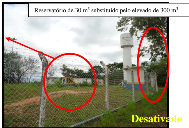
Figura 32 - Reservatórios Elevado Florianópolis II (300 m 3 ) que substituiu o Reservatório Elevado Florianópolis (30 m 3 ) - Terras do Capela
