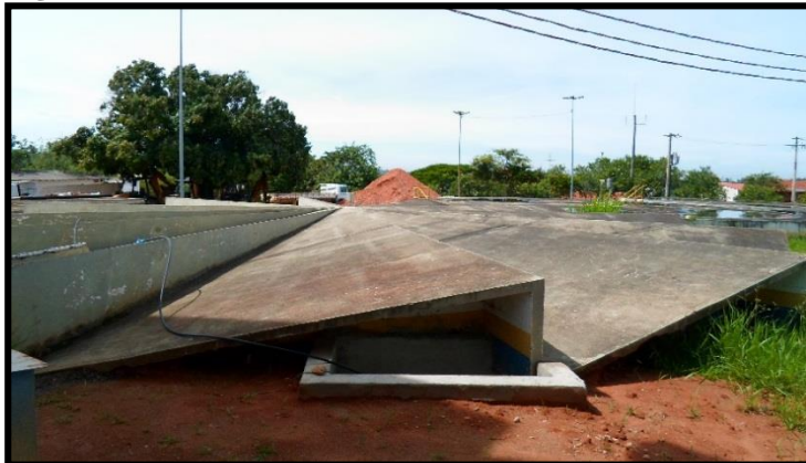
Figura 12 - Reservatório Semi-enterrado R1 - ETA Central.
