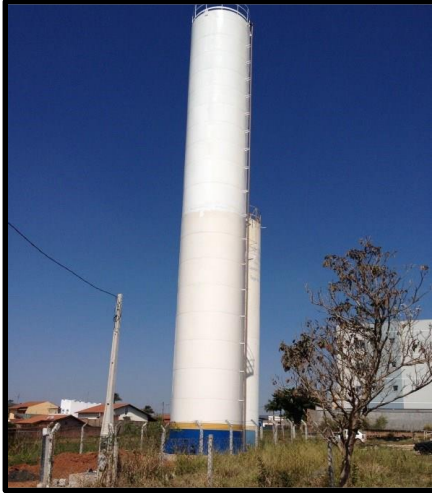
Figura 31 - Reservatório Parque dos Ipês (300 m 3 ).
