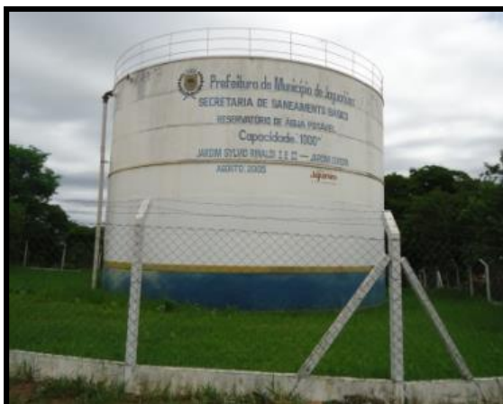
Figura 28 - Reservatório Sylvio Rinaldi I (1.000 m 3 ).
