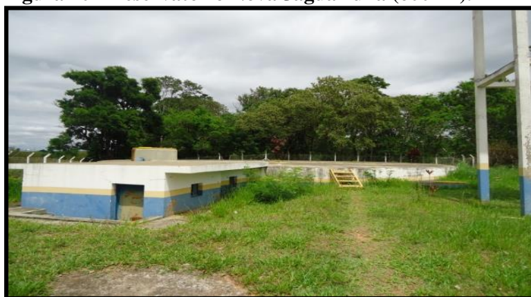
Figura 20 - Reservatório Nova Jaguariúna ( 600\text{ m}^3 ).
