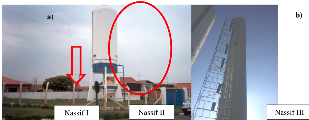
Figura 27 – Reservatório Enterrado Nassif I (1.200 m 3 ); Reservatório Elevado Nassif II (100m 3 ) e, Reservatório Elevado Nassif III (125 m 3 ).
