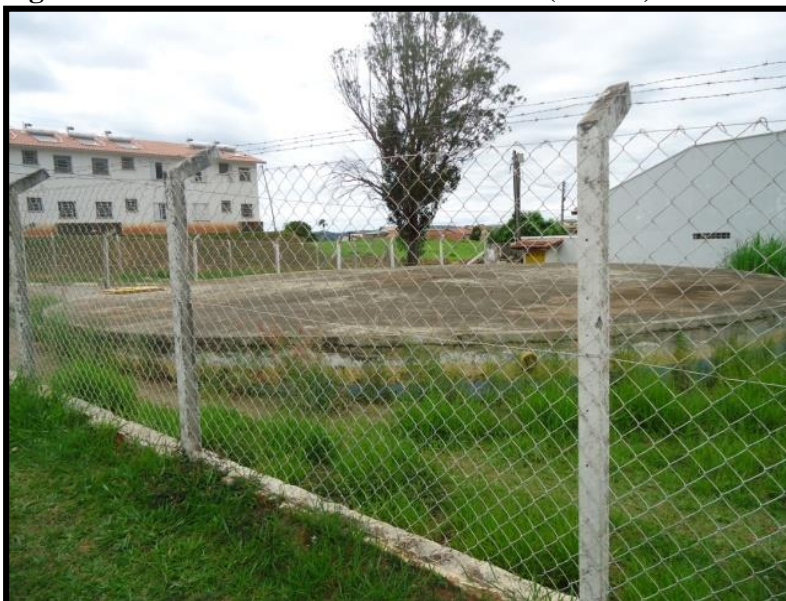
Figura 22 - Reservatório Cruzeiro do Sul (600 m 3 ).
