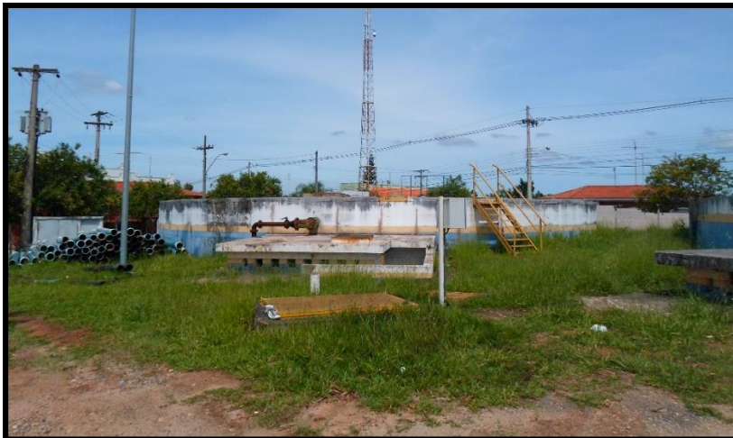
Figura 15 - Reservatório Semi-enterrado R4 - ETA Central.
