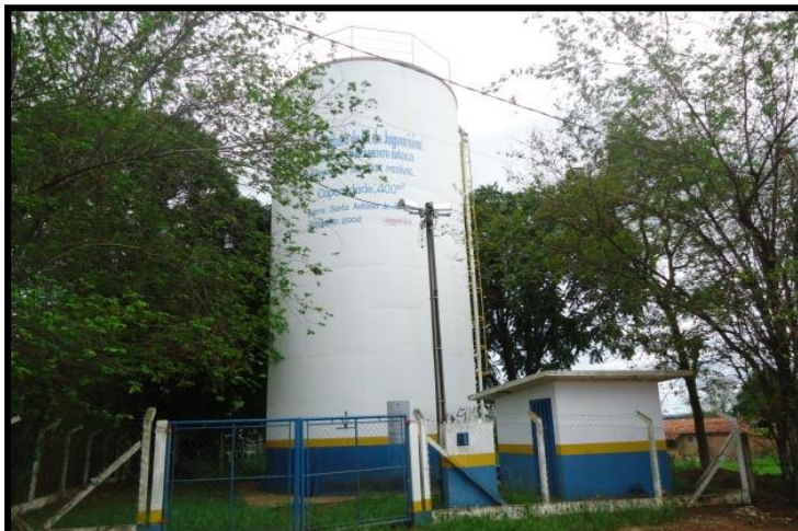
Figura 18 - Reservatório Santo Antônio do Jardim (400 m³).
