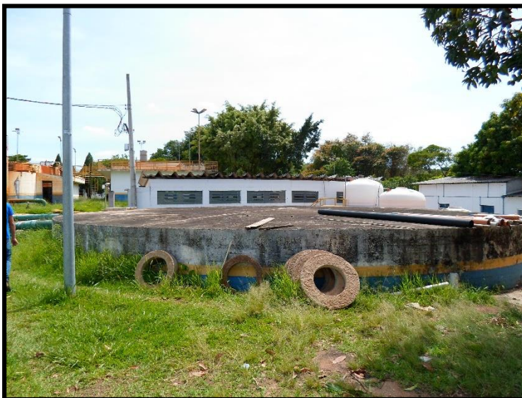
Figura 13 - Reservatório Semi-enterrado R2 - ETA Central.
