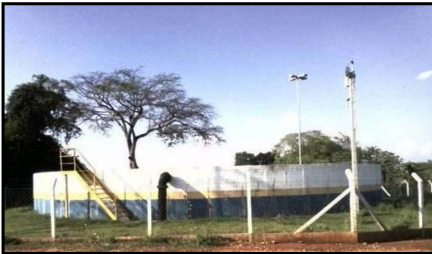
Figura 25 - Reservatório Capotuna I (1.200 m 3 ).
