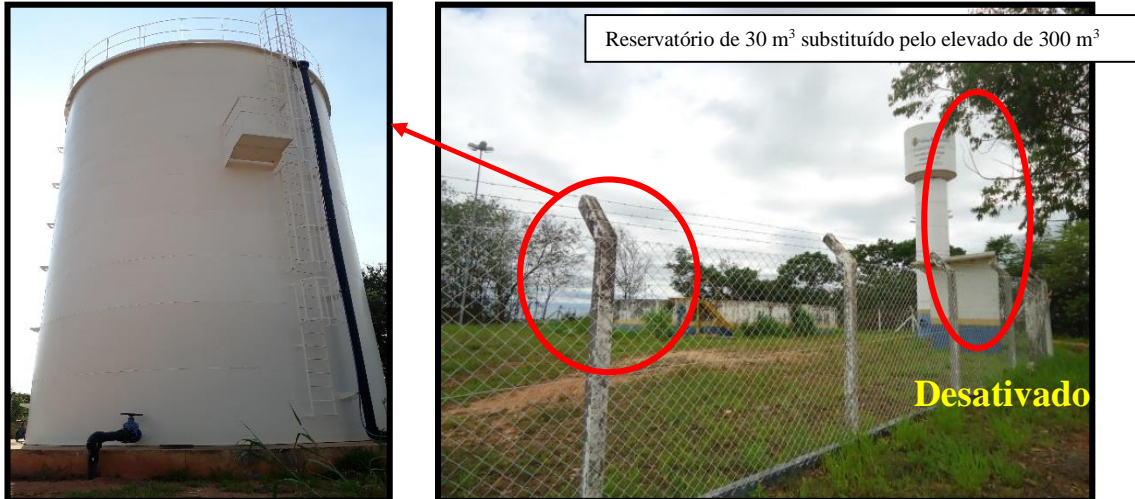
Figura 33 - Reservatórios Elevado Florianópolis II (300 m 3 ) que substituiu o Reservatório Elevado Florianópolis (30 m 3 ) - Terras do Capela
